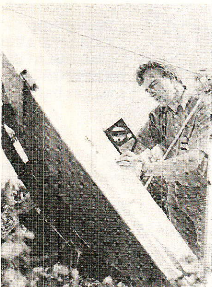
Réglage monture fixe : afin d'obtenir l'indication la plus fiable quant à l'angle d'élévation on applique l'inclinomètre sur une règle coupant verticalement en son milieu le réflecteur recevant en bordure cette dernière.
