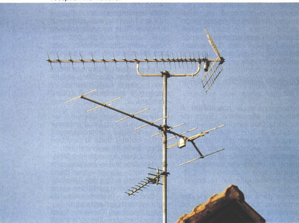
Figure 2 : Ensemble d'antennes de réception individuelle.
