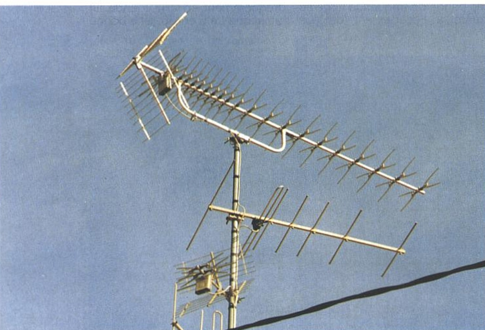
Figure 8 : Une antenne UHF (en haut) et une antenne VHF (en dessous).
