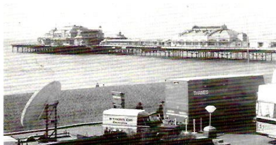
Cars de reportage, antennes satellite et tous les grands équipements de l'IBC ont été exposés sur le parking à côté de la plage à Brighton. Derrière les équipements on voit la jetée de Brighton.
