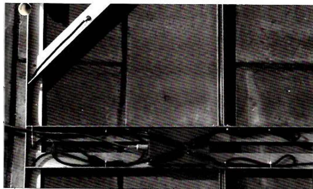
Une partie du cadre supportant les antennes. Vu de dessous, on distingue bien le boîtier de commutation des antennes.
