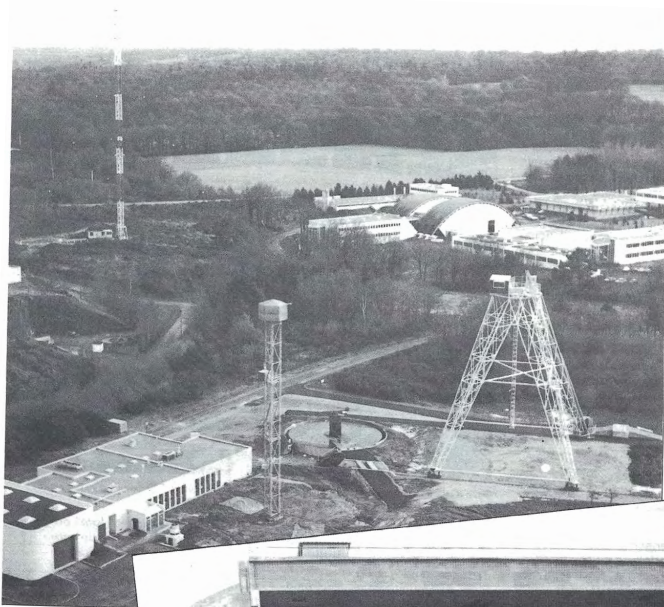
Photo 2 — Vue aérienne des bases extérieures de mesure électromagnétique.
