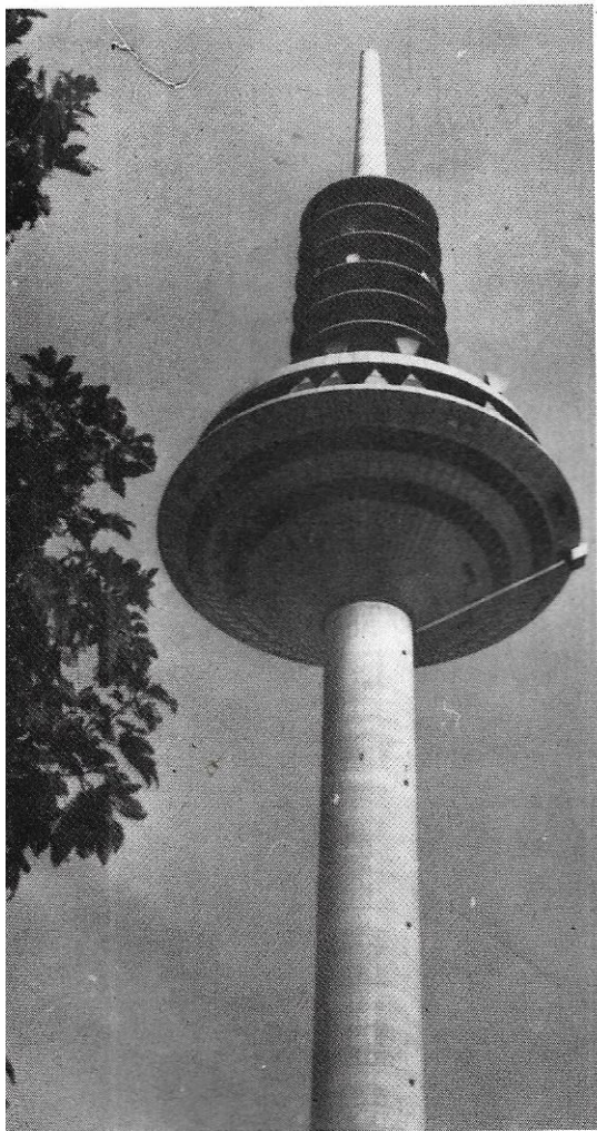
Pylône du centre émetteur de FRANKFURT
