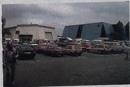
Vue parking intérieur.
