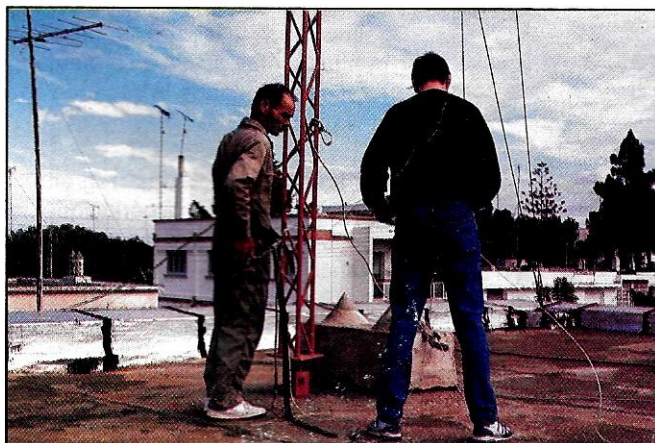
Montage des antennes : F6ATQ et F6BQY
