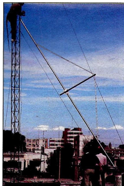
Montage de l'antenne 2 él. 40 m. En haut du pylône : F6ATQ
