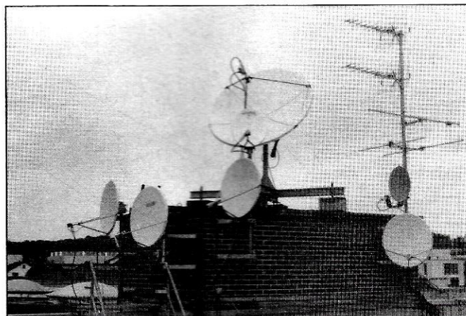
Les antennes satellite de Saditel.
