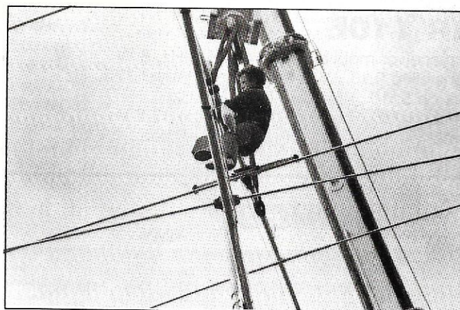
Le SWL Edmond en haut du pylône.
