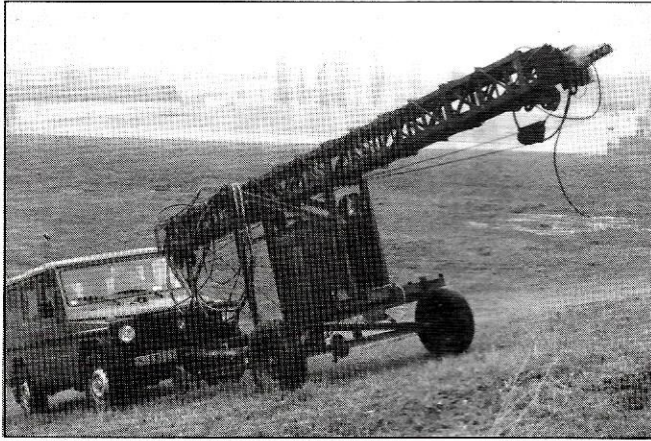
Une anclenne grue transformée en pylône pour les besoins radioamateur (F6IMS).
