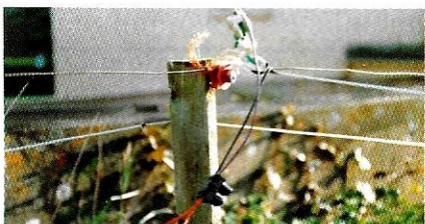
Le branchement du Twin lead de la delta loop.
