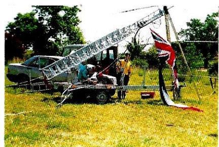
Montage et réglage du pylône.
