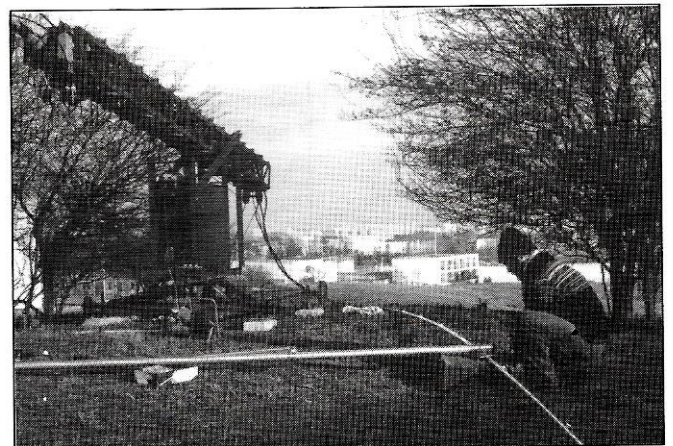
Montage des antennes. Dans le fond : Genève.
