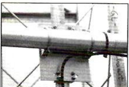
Pièce de fixation boom/pylône.
