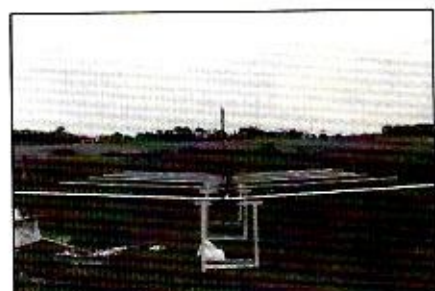
Vue de l'ensemble monté. Remarquez l'inclinaison vers le haut des éléments. Cette position est obtenue grâce à la forme particulière des supports prévue pour compenser un éventuel affaissement dans le temps.
