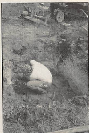
Ferrailage du béton.
