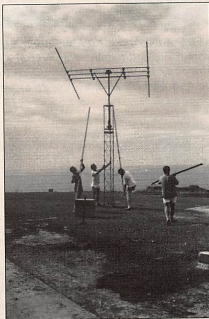
Montage de la structure support d'antennes.
