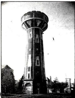
Le château d'eau abritant le radio-club de Neuville de Poitou, FF1OFL.
