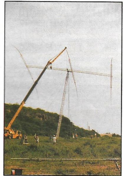
Montage de l'antenne 80 m avec une grue.
