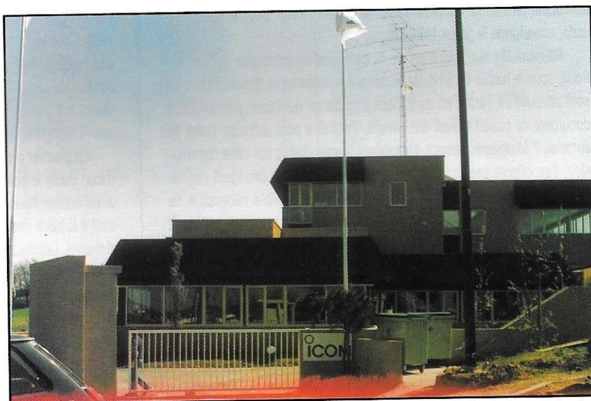
Les nouveaux locaux d'Icom France.
