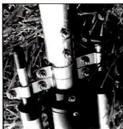
Montage des tiges condensateurs.
