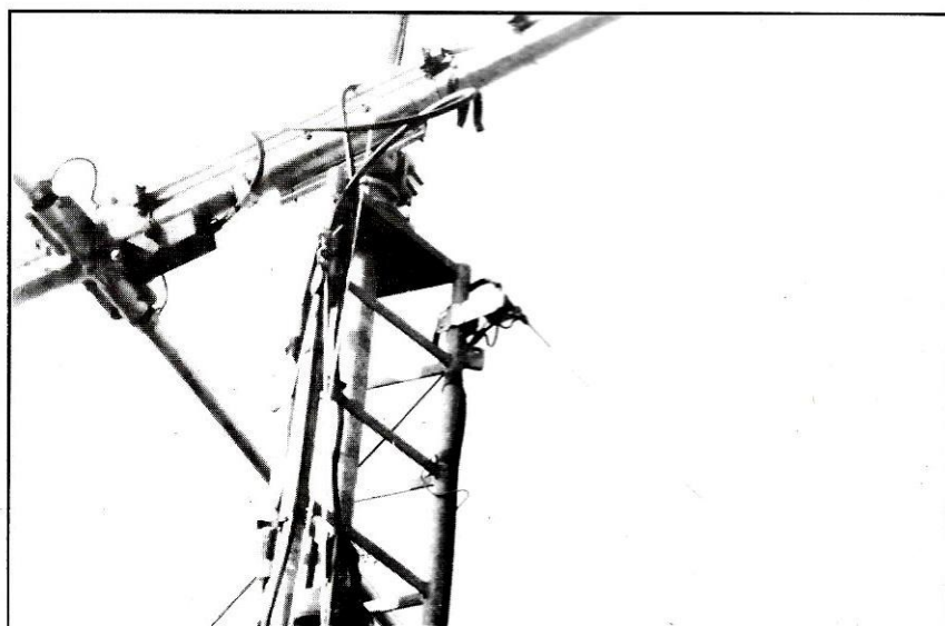
Fixation en haut du pylône.
