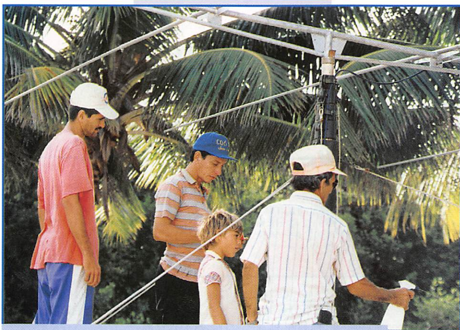
CO6DS, au montage des aériens.
