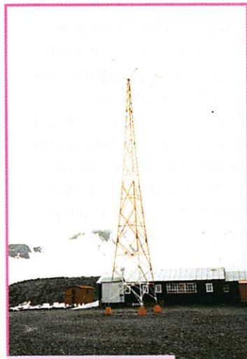
Un beau pylône !
