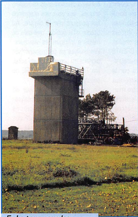
5. La tour pour les mesures en ondes de sol.
