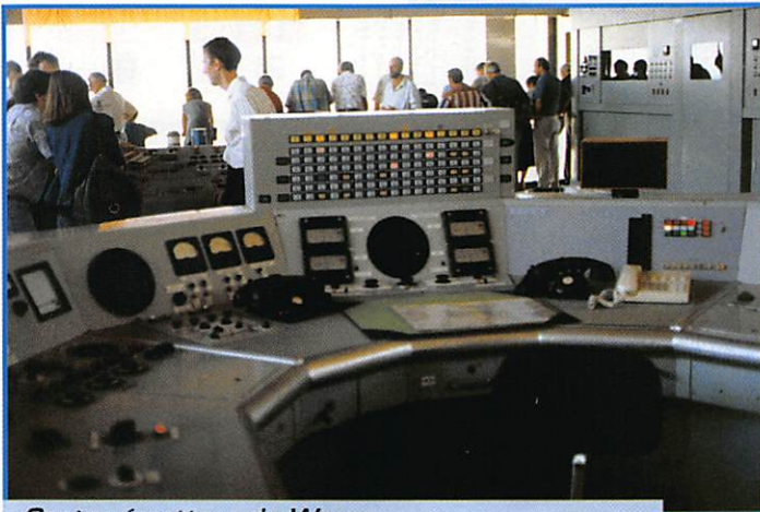
Centre émetteur de Wavre. Le pupitre pour alimenter les antennes.
