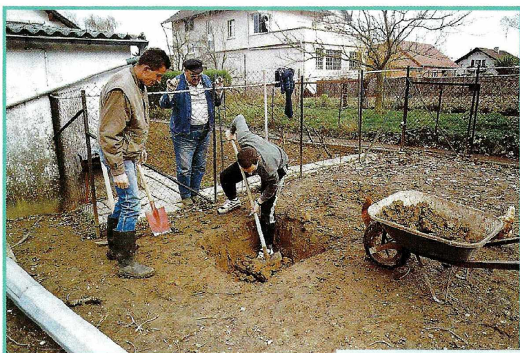
Creuser. Fondations du pylône.
