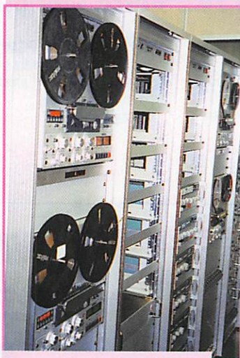
Station automatique RTTY (Sitor). Les trous correspondent aux appareils retirés après diminution du service.
