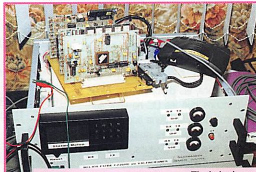
Tiroir logique relais en cours de montage.
