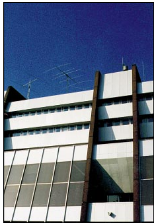
A gauche : 2 élém. beam 40m. Au centre : 5 élém. beam 10-15-20m. A droite : 3 élém. beam WARC.
