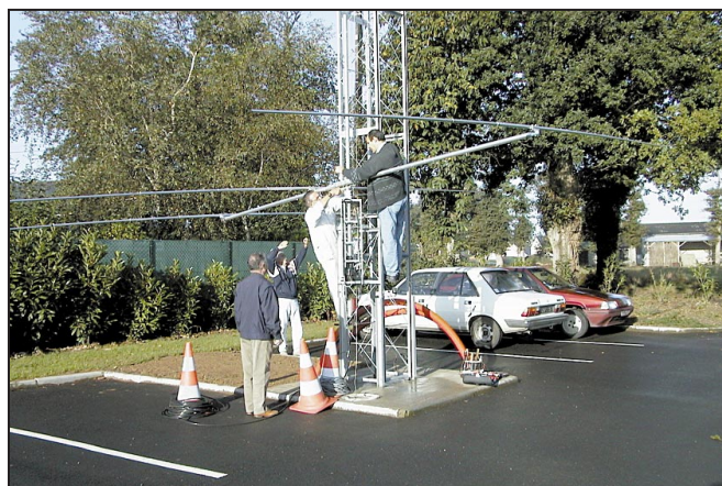
Montage d'une 3 éléments 18 MHz.
