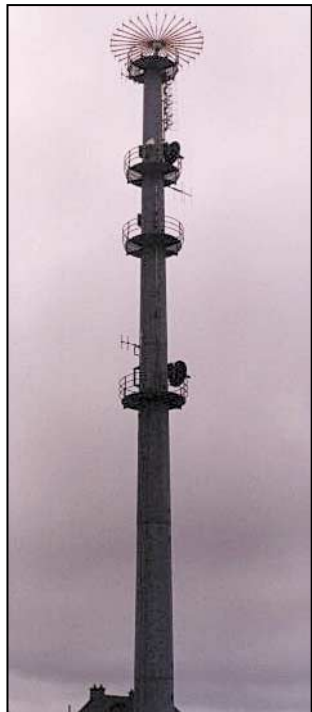
Les antennes du CROSS Jobourg.
