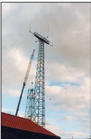
Boulogne : On démonte déjà !
