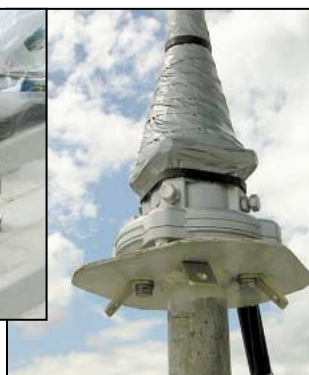
La platine soutenant le roulement. Notez l'étanchéité réalisée sur la partie supérieure du roulement.
