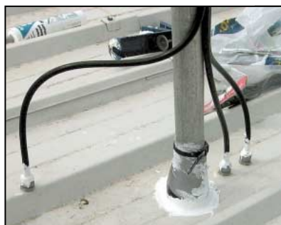
Traversées du mât porteur et des câbles.
