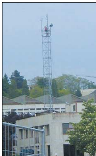
Le pylône du relais.
