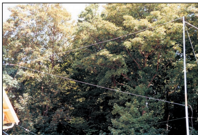
L'antenne en question ! Nota : le brin filaire inférieur est parallèle au sol (hauteur 5 m). A droite sur la photo : 2 haubans en fil nylon, diam. 2,5 mm.
