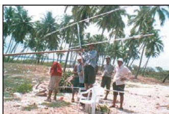
Assemblage d'une antenne.
