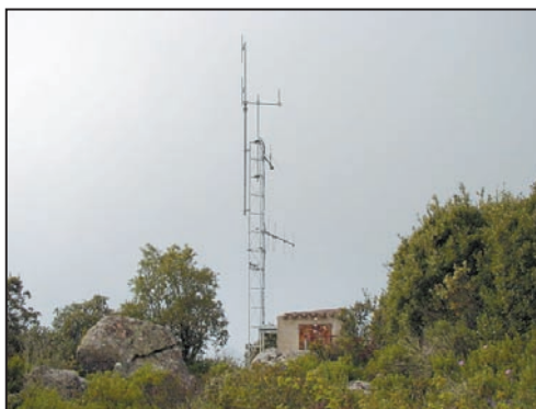
Le pylône de Coti-Chjavari, au nord d'Ajaccio.
