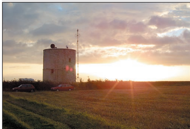
Une vue du site avec la complicité du soleil.
