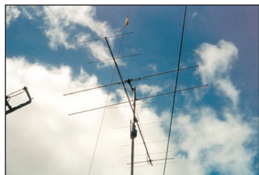
Les antennes de CN2DX à Casa.
