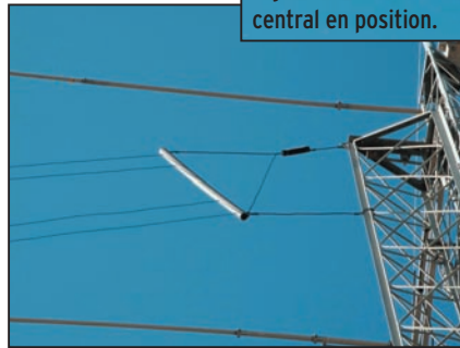
Figure 13: La fixation au sommet du pylône. L'isolateur est décalé vers le haut et un câble permet d'assurer la verticalité du support PVC.
