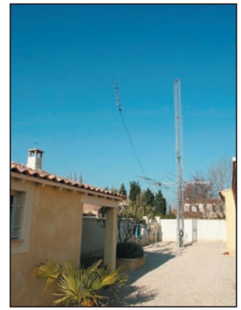
Figure 14: Réalisation terminée. L'antenne XP507 est en position basse, sans perturber le fonctionnement de la L2T2FD.
