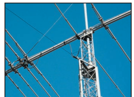
Figure 4: La fixation au sommet du pylône.
