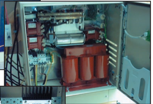
5 et 6 - Le câblage de l'installation.
