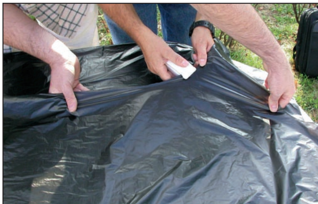
1 - Soudure à chaud du plastique de l'enveloppe.
