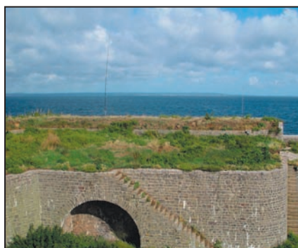
3 - On devine les antennes.
