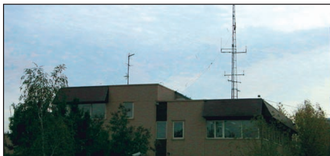
1 - Une vue du bâtiment. Absente du pylône, la beam déca, descendue pour maintenance.
