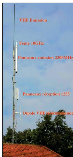
3 - Filtres réjecteurs pour les antennes.
