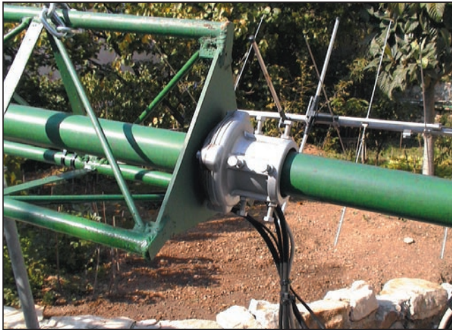
Photo n° 6 : Plaque du support du roulement de mât.
