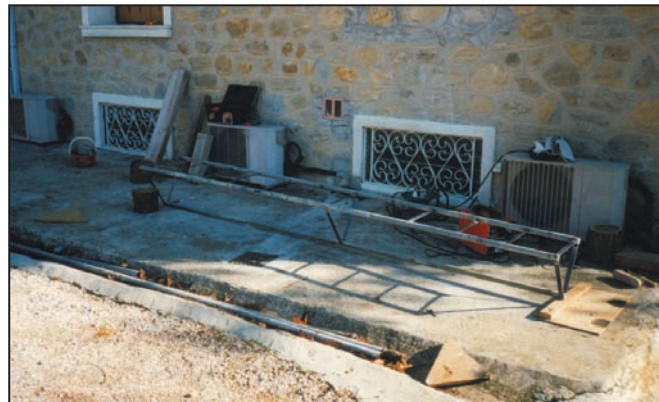
Photo n°1: Tronçon n°2 en cours de fabrication.
