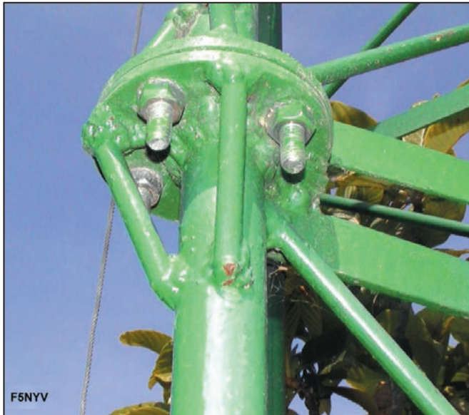
Photo n°2: Exemple de soudage de renfort.
