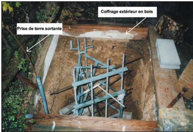
Photo n° 10 : Chaise prête à être coulée.
