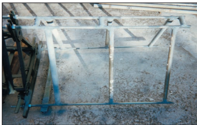
Photo n° 7: Chaise en cours de construction et fixée sur le tronçon 1.
