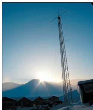
5 - La beam 5 éléments à 30 mètres.
