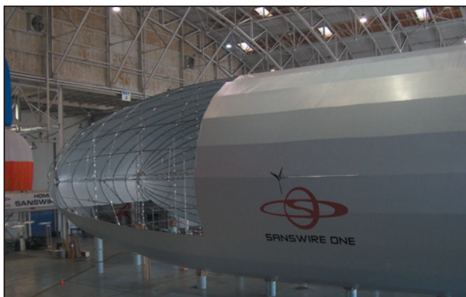
2 - Le Sanswire One en cours de construction.
