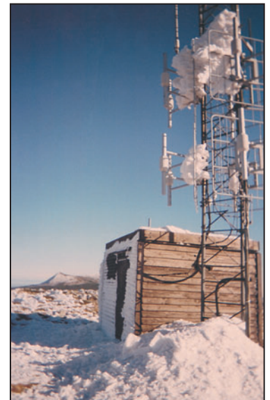
3 - La cabane et le pylône du relais du Mt. Alambre, R5X, avec, au fond, le Mt. Mézenc.
