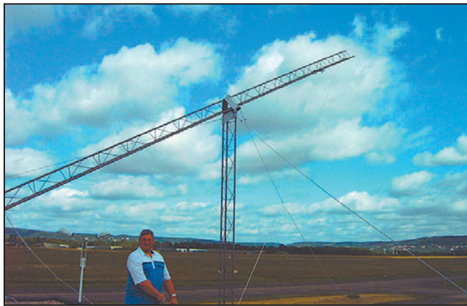
2 - Le pylône et FITEA.
