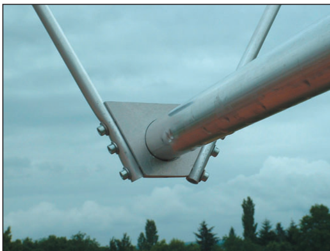
4 - La fixation d'un triangle sur le support à l'aide de 6 vis BTR.
