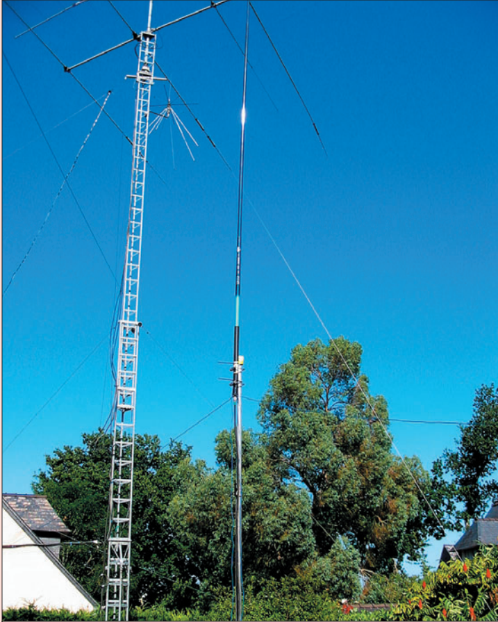
4 - Les haubans d'un mât ou d'un pylône peuvent présenter un danger dans un jardin fréquenté par des enfants.
