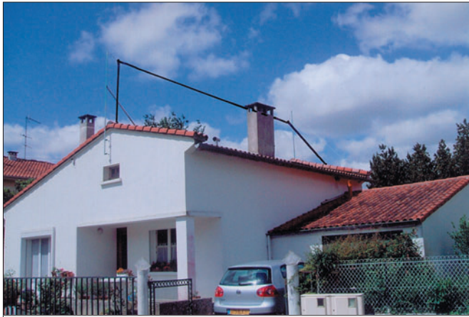
2A - Photo de l'antenne prise depuis la rue, côté droit.
