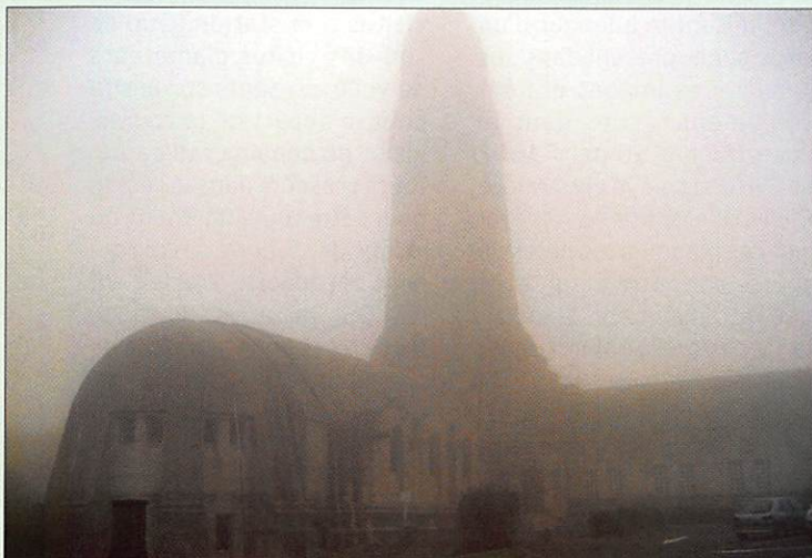
Curieuse ambiance que celle qui se dégage de cette photo de l'ossuaire émergeant du brouillard...
