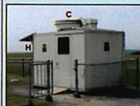
Lanceur automatique de radiosondes à Saint-Hubert (Belgique). Sous l'airain H sont rangées les bombes à l'hélium. Le ballon gonfle à l'heure prévue par le trappeur C à l'heure programmée.
