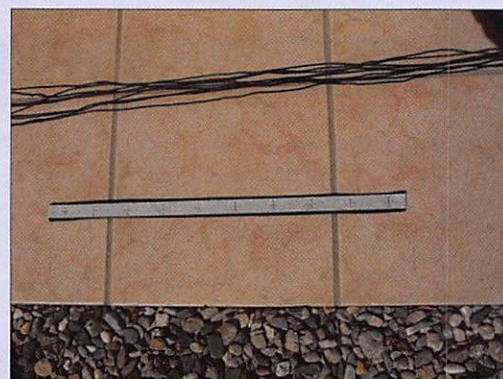
4 - Une bande adhésive pour marquer les perçages.
